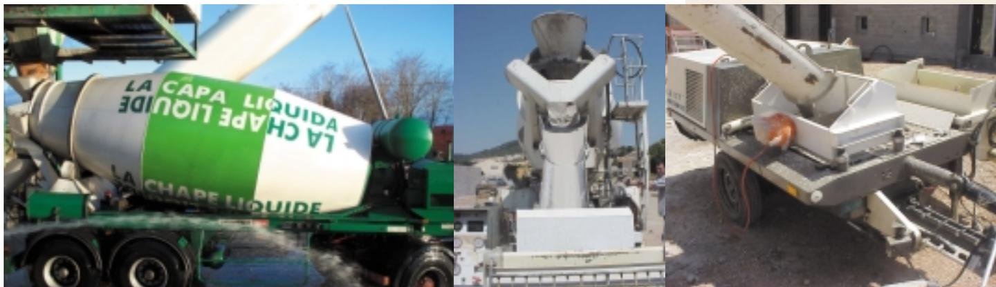
La Chape Liquide® est un mortier fluide à base de sulfate de calcium, préparé industriellement en centrale à béton et mis en œuvre sur chantier par pompage.
