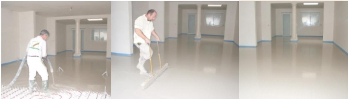
La légèreté, les capacités de rattrapage de défaut de planéité et les épaisseurs réduites de La Chape Liquide® en font la solution idéale pour la rénovation et la réhabilitation des sols.
